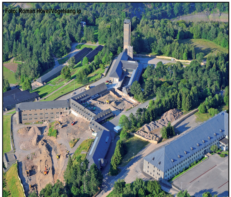
Eine Symbiose aus Denkmalschutz und Weiterentwicklung ist möglich, wie die Baustellen in Vogelsang schon jetzt zeigen
