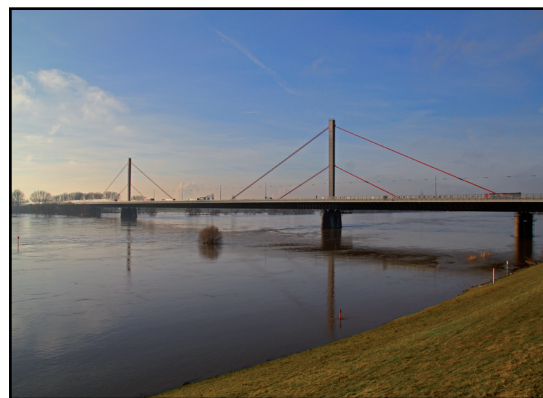
Die Leverkusener Autobahnbrücke ist seit dem 3. März wieder für den Schwerlastverkehr freigegeben
